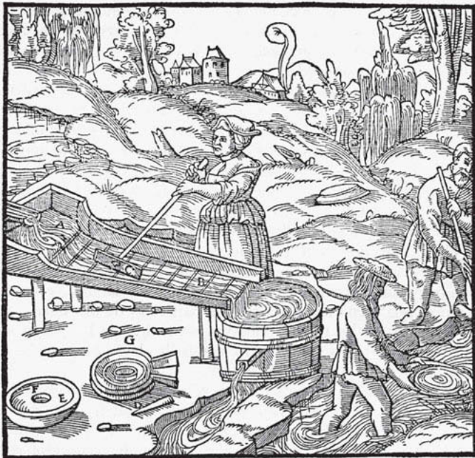
Figura 5. Sistema lusitano para el lavado de arenas auríferas. Figure 5. Lusitanian System for washing auriferous sand.
