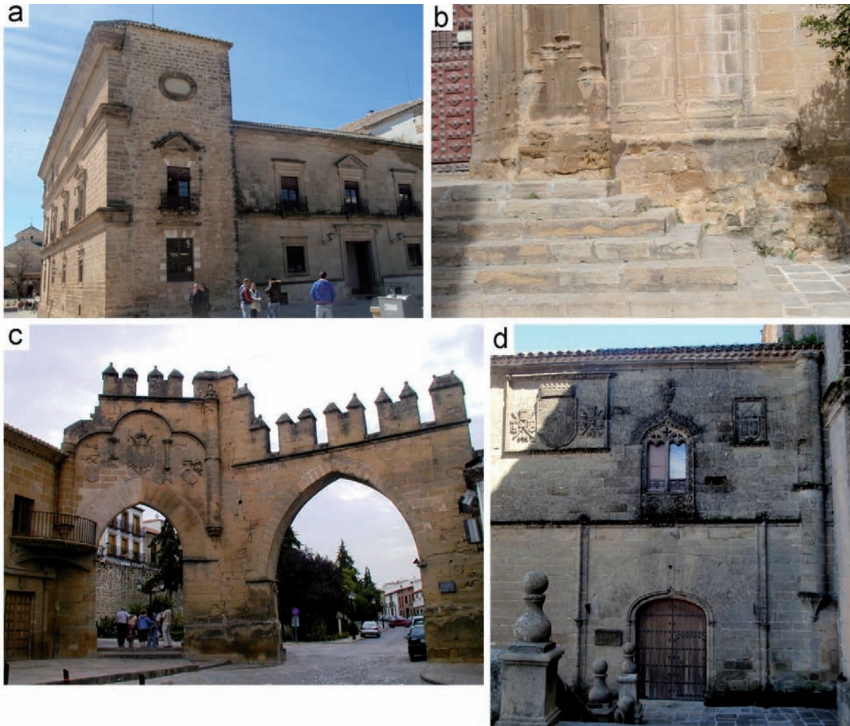
Figura 5. Algunos ejemplos de deterioros observados: a) Colonización biológica en la cornisa y en la zona de la bajante, en el Ayuntamiento de Úbeda; b) Deterioro del exterior de la iglesia de San Pablo (Úbeda) en el que se observa un fuerte proceso de arenización y/o erosión alveolar y eflorescencias; c) Puerta de Jaén y Arco de Villalar (Baeza), donde destaca la presencia de costras negras; d) Catedral de Baeza, donde se observa gran cantidad de colonización biológica, eflorescencias y costras negras, entre otros deterioros. Figure 5. Examples of deterioration observed: a) biological colonization on the ledge and in the downpipe, in the city of Úbeda; b) deterioration of the exterior of the church of San Pablo (Úbeda) showing a strong process of grain disaggregation and/or alveolar erosion and efflorescence; c) Gate of Jaén and Arch of Villalar (Baeza), with the presence of black crusts which highlights the decay of the Gate of Jaén and Arch of Villalar (Baeza); d) Cathedral of Baeza, where many biological colonizations, black crusts and efflorescence are observed, among other damage.
