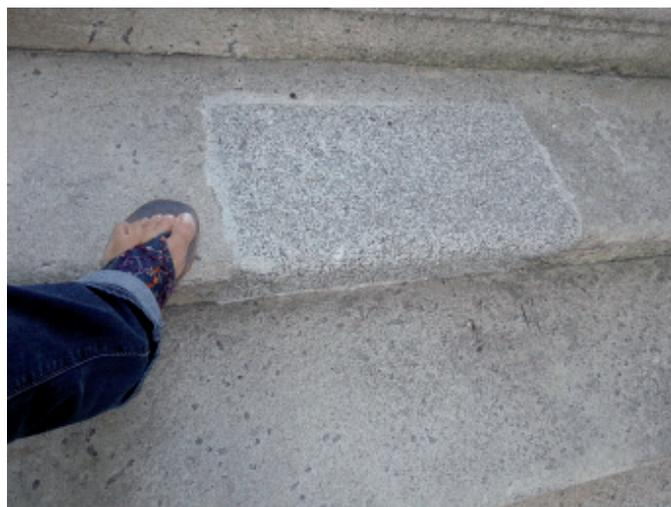
**Figura 3.** Contraste estético y posiblemente estructural entre el granito Los Santos y el granito de Martinamor. El primero sustituye a una pieza deteriorada del segundo en la mitad de una escalera que da acceso a la terraza de la Casa Lis, museo Art Decó en Salamanca.
