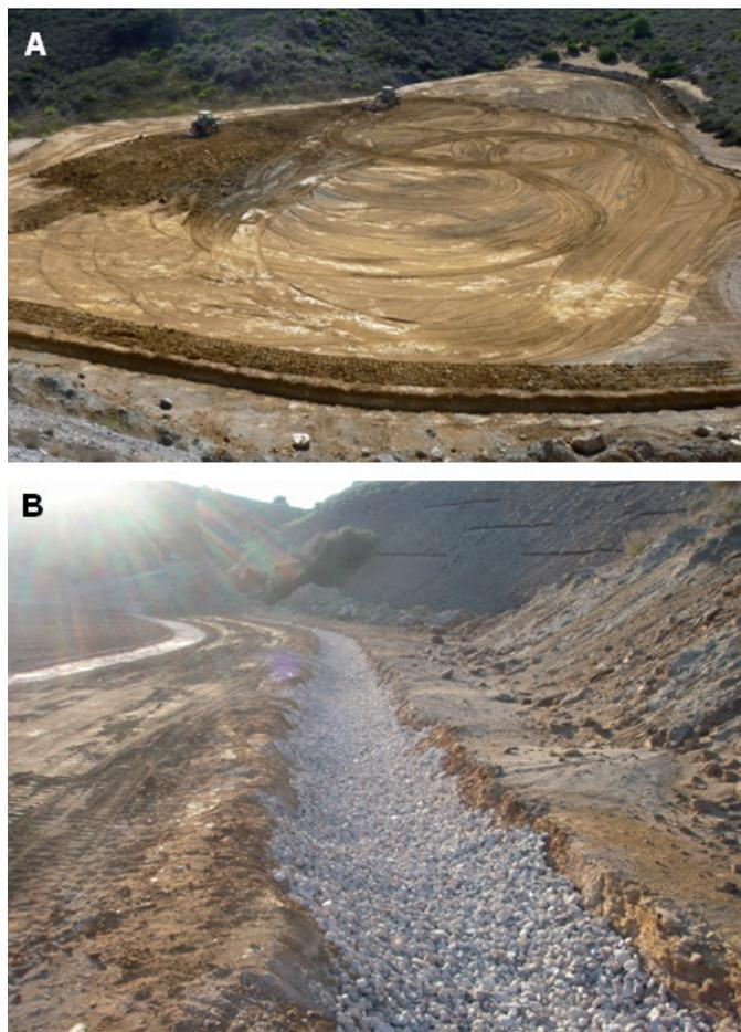
**Figura 2.** Imágenes de la nivelación de la superficie (A) y de la creación de un sistema de drenaje (B).
