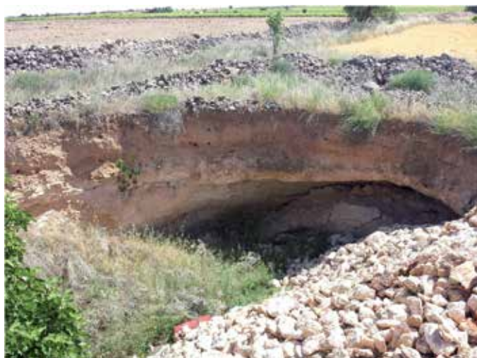
Figura 12. Ejemplo de colapso de tipo intermedio (n°27, El Tallar). Figure 12. Example of collapse of intermediate type (n°27, El Tallar).
