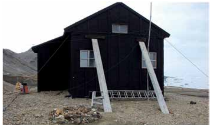
Figura 2. Reparaciones de la estructura externa y apuntalamiento del actual Museo Nordenskjöld. Figure 2. External structure repair and propping of the Nordenskjöld Museum.
