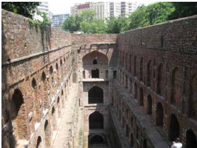
Figure 1. Baolis or step wells for groundwater recharge and development. Figura 1. Pozo con escaleras en Baolis para recarga artificial.
