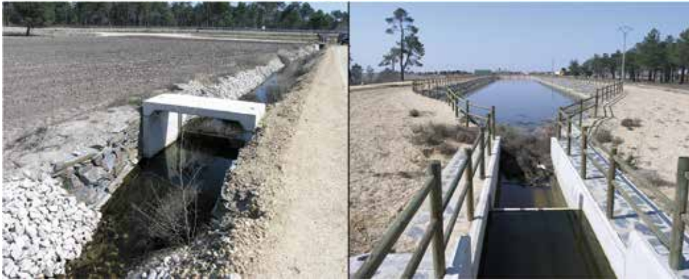
Fotografías 4 y 5. Canal y balsa de infiltración. Photographs 4 and 5. Channel and infiltration pond.
