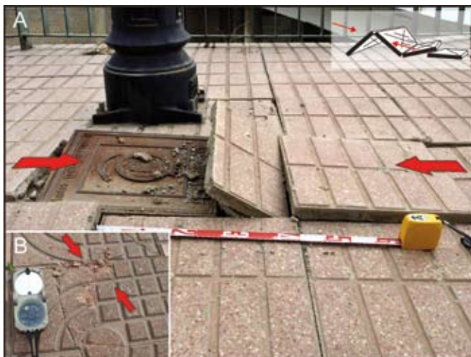
Figura 3. A) Pliegues en enlosados regulares indicando una dirección de acortamiento N140°E; B) marca de impacto en el enlosado con una dirección de acortamiento N 175°E. Las flechas rojas indican las direcciones de acortamiento.
