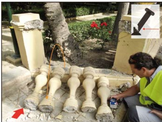
Figura 6. Caída orientada de columnas en la balaustrada del jardín del antiguo Cuartel de Infantería de Lorca. Dirección y sentido de caída hacia los N330°E, la flecha roja indica la dirección y sentido del movimiento del sustrato para poder producir esta caída.
