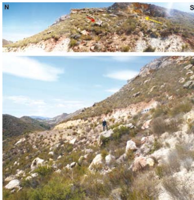
Figura 5. Imagen en detalle de los desprendimientos rocosos de la Rambla de los 17 Arcos. Arriba. La flecha amarilla indica los bloques desprendidos durante el terremoto del 11 de mayo del año 2011. La flecha roja señala bloques desprendidos con anterioridad. Es sobre éstos donde se aplica la liquenometría. Inferior. Detalle general de los bloques desprendidos.
