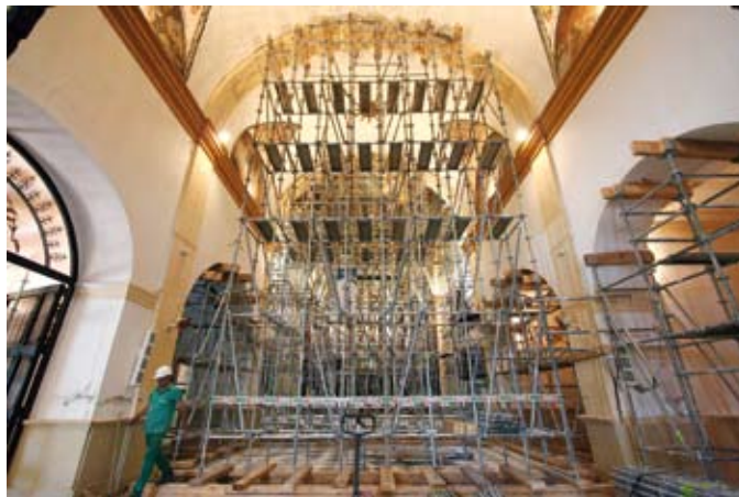
Figura 28. Apeo de los arcos formeros de la nave central de la Iglesia de Virgen de las Huertas. Figure 28. Propping up of the arches over the nave of the church of the Virgen de las Huertas.
