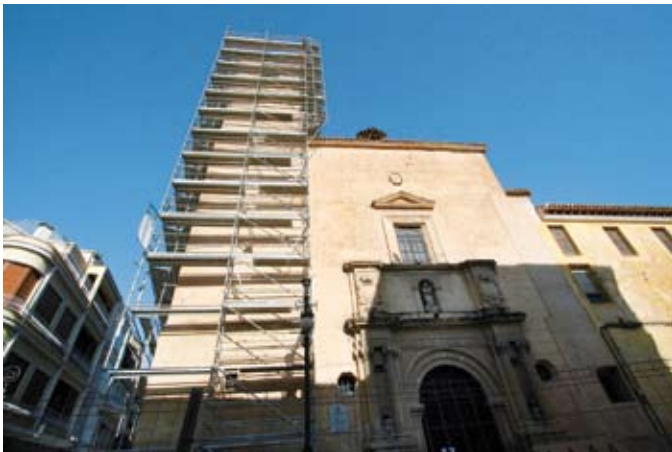
Figura 31. Obras de emergencia en la Iglesia de San Francisco. Figure 31. Emergency work on the church of San Francisco.
