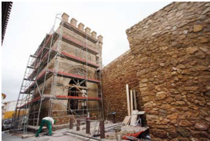
Figura 26. Obras de emergencia en el Porche de San Antonio. Muralla de Lorca. Figure 26. Emergency work on the porch of San Antonio in Lorca's city wall.
