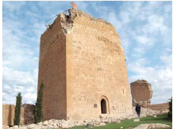
Figura 1. Daños en el volumen de la Torre del Espolón. Castillo de Lorca.
