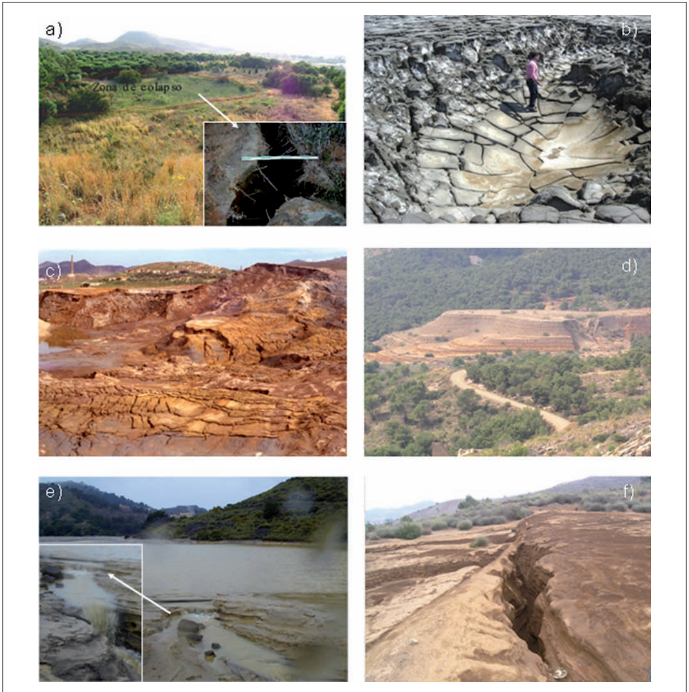
Figura 12. a) Colapso de la presa Marqués de Peja, b) colapso de la presa Tomasa, c) deslizamiento presa Brunita, d) deslizamiento presa Peña del Águila, e) Sobrepasso presa El Lirio (11/04/2004) y f) erosión en cárcavas presa Rosa Figure 12. a) collapse of the Marques de Peja tailings dam; b) collapse of the Tomasa tailings dam; c) landslide in the Brunita tailings dam; d) landslide in the Peña del Águila tailings dam; e) overflow of the El Lirio tailings dam (11/04/2004); f) badlands gully erosion at the Rosa tailings dam
