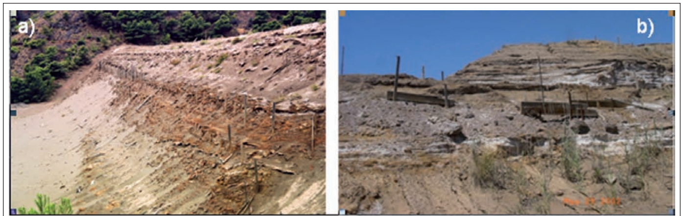
Figura 3. Sistema de construcción de las presas de lodos de flotación en Sierra Minera de Cartagena –La Unión: presa El Lirio y b) Presa Santa Antonieta
