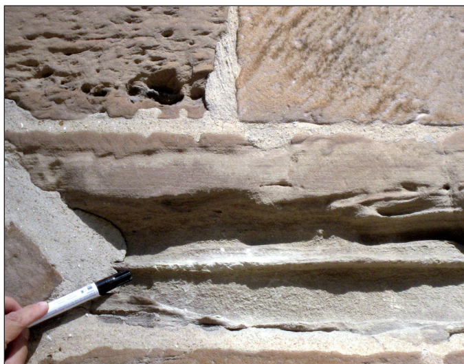
Figura 11. Acanaladuras en sillares de arenisca de La Grandiella Figure 11. Striation in the La Grandiella sandstone blocks
