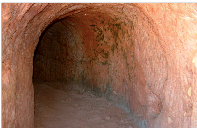
Figura 2. Galería romana de exploración (Filón Sur, Tharsis) Figure 2. Roman prospecting gallery (south lode, Tharsis mine)
