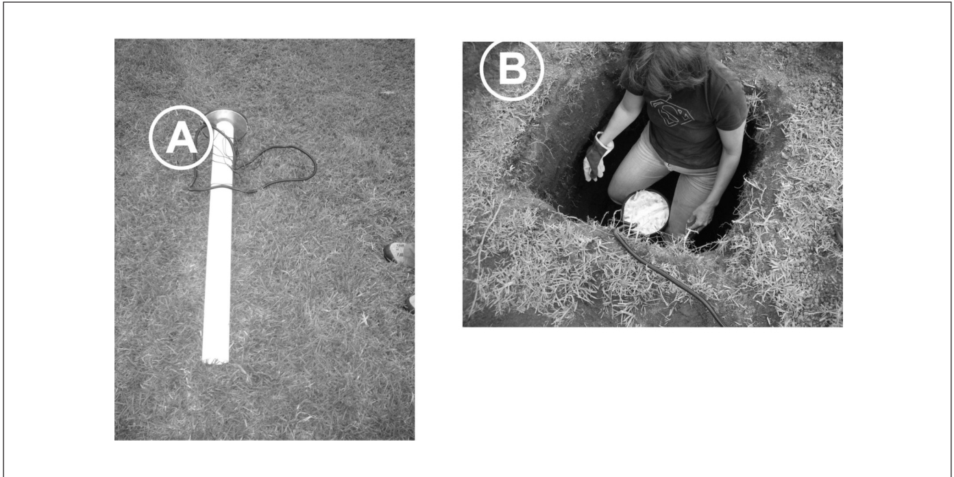
Figura 3. Instalación del lisímetro (Drain Gouge, Decagon Devices, Inc.) en el campo de golf de Bandama. (A): tubo colector antes de la instalación, (B): calicata practicada para la instalación del lisímetro, obsérvese el tubo por donde se lleva a cabo la succión para tomar las muestras
