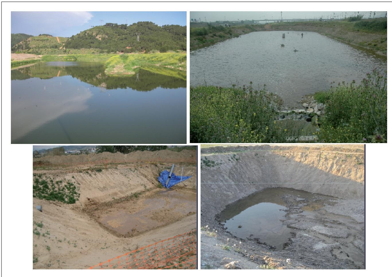
Figura 5. Balsas de recarga artificial en fase de construcción en el Valle Bajo del Llobregat y. Se muestran las balsas de Can Albareda (arriba, izq.), las de Sant Vicenç (arriba der.) y las de Sta. Coloma (abajo). El volumen total de recarga se estima que será de 6 a 10 hm<sup>3</sup>/año
