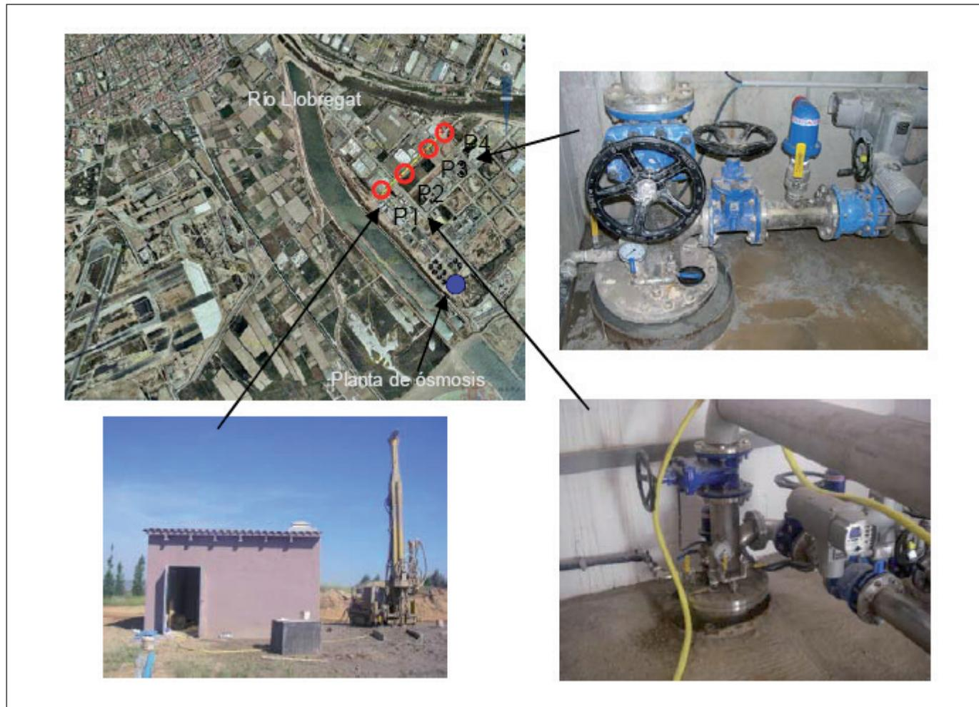
Figura 9. Detalle de los pozos de inyección de la primera fase de la barrera hidráulica. Los pozos están equipados con controladores automáticos de caudal, sondas de nivel y electrobombas para la limpieza
