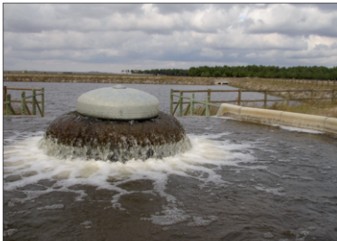
Figura 10. Aspecto de la cabecera del canal con un caudal de entrada superior a 750 l/s (Santiuste, 2 de junio de 2008) Figure 10. Aspect of the headwaters of the canal with a flow rate of entry major than 750 l/s (Santiuste, June 2 nd , 2008)
