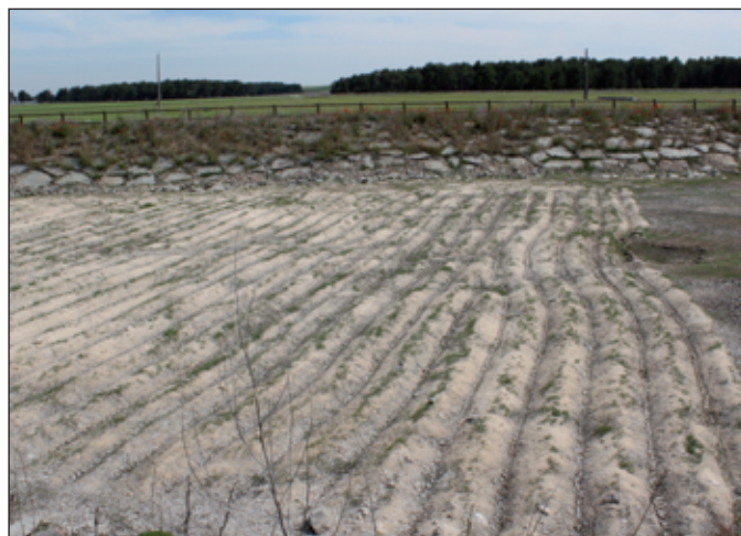
Figuras 11 a) y b). Caballones arados con distinta anchura en el fondo de una balsa de decantación e infiltración (cabecera del dispositivo de la Cubeta de Santiuste)
