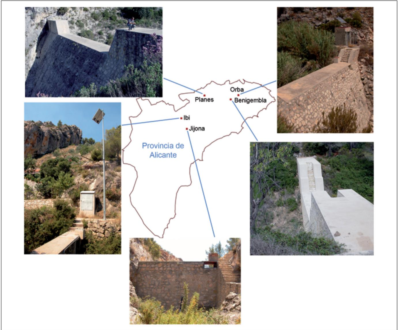
Figura 5. Presas instrumentadas para teledeteción de niveles de llenado y caudales de desborde
