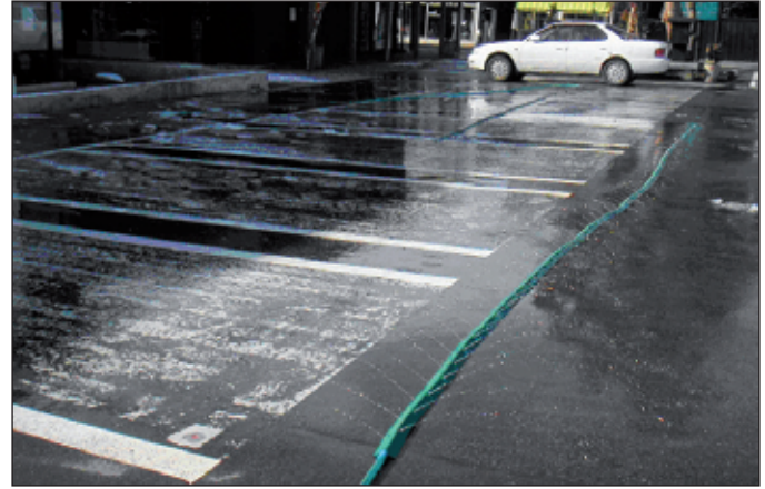
Figure 5. Groundwater used for the melting snow on a parking lot, Jan. 07, 2004 Figura 5. Agua subterránea utilizada para fundir la nieve en un aparcamiento. Enero 2004
