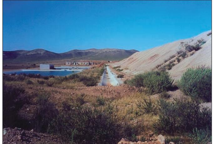
Figura 11. Pilas de lixiviación y balsas que recogían el líquido enriquecido en oro en el año 1990
