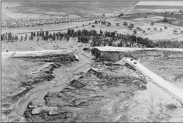
Figura 12.3.- Vista aérea de la ruptura del dique de la balsa y de los materiales vertidos hacia el cauce del río Agrio. Se aprecia el espigón de separación entre la balsa de piroclastos (lado izquierdo) y la de sulfuros (lado derecho).
