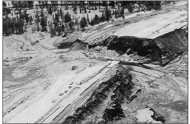
Figura 12.4.- Detalle de la zona de ruptura del dique de la balsa de lodos.
