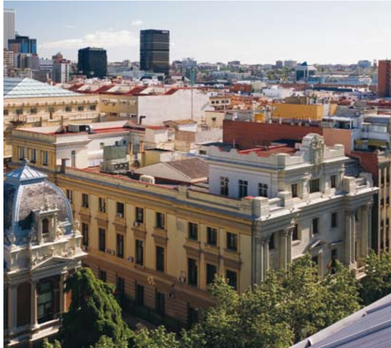
Fachada principal (vista desde la calle Ríos Rosas)
