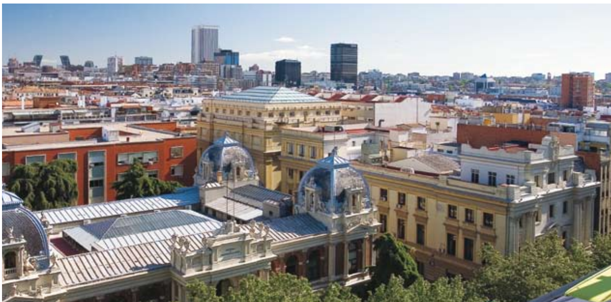
Conjunto del edificio entre las calles Ríos Rosas y Cristóbal Bordiú. En primer término, a la izquierda, la Escuela de Minas
