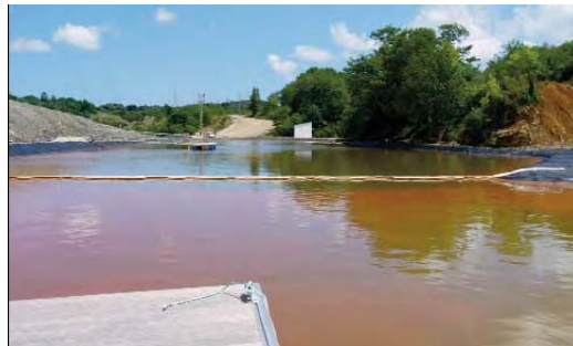
Balsa de decantación del agua de la corta de Reocín tras su tratamiento.
