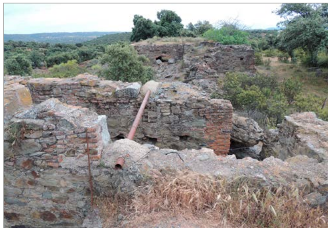
Fig. 19. En primer plano, pozo maestro o principal del Grupo Minero “Los Almadenes”. En segundo plano, casa de máquinas del mismo pozo. Foto: B. Rodríguez (abril 2017).
