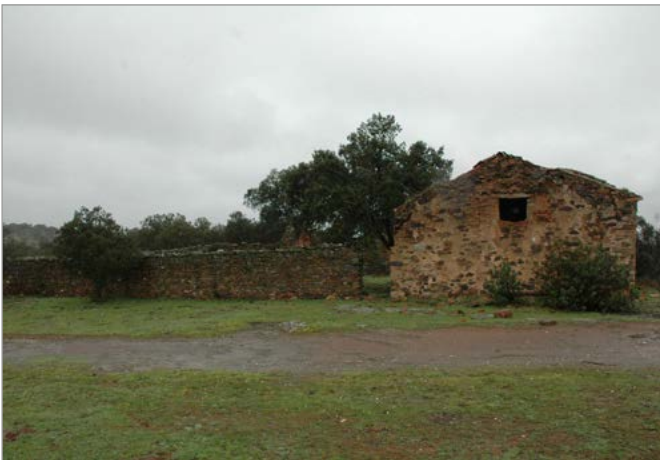
Fig. 52. Antigua escuela para los hijos de los mineros, vista desde el camino de acceso a la misma. Foto: I. Ramos (marzo 2018).
