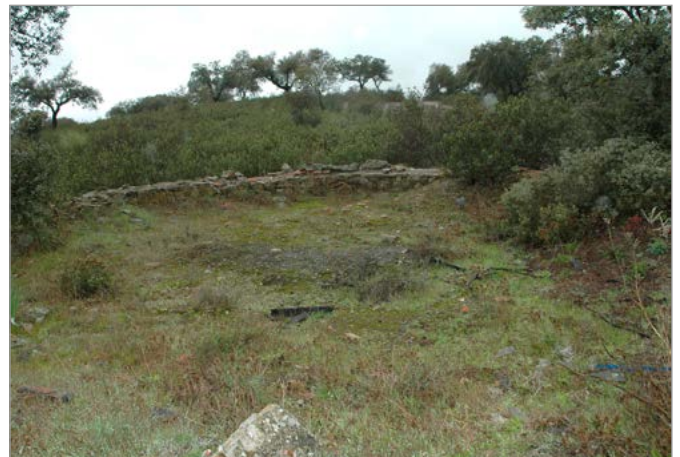
Fig. 46. Restos de un depósito circular de unos 10 m de diámetro, próximo al pozo maestro, y conectado con sus instalaciones mediante tubería de hierro enterrada. Está situado cercano al depósito de la figura 41, del cual dista unos 75 metros. Foto: I. Ramos (marzo 2018).
