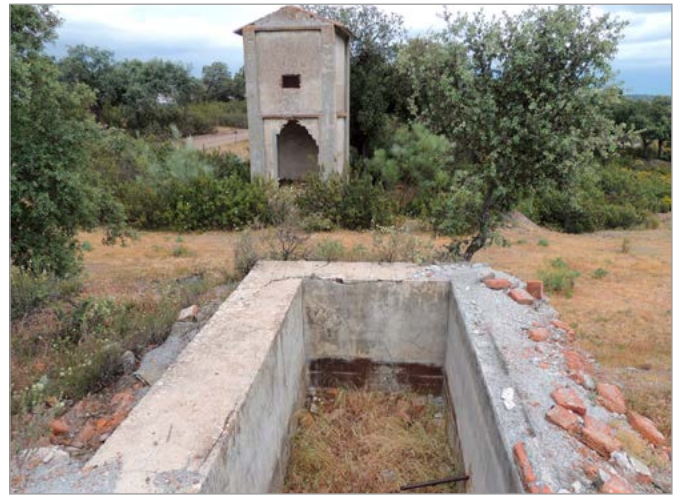
Fig. 44. Caseta de transformador y depósito próximos al pozo maestro. Foto: B. Rodríguez (abril, 2017).
