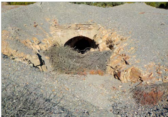
Fig. 28. Posible galería que conduciría los estériles del lavadero destinados a relleno hidráulico hacia pozo vertical ubicado en su interior. Foto: I. Ramos (mayo 2017).
