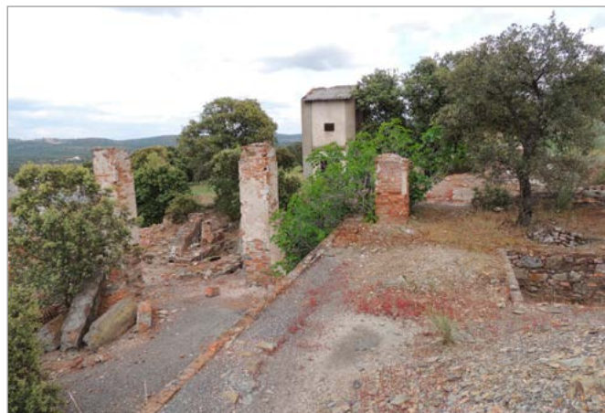
Fig. 48. Zona lateral del lavadero moderno. Al fondo, tras la higuera, y con tejado de chapa, se ve la caseta del transformador. Foto: B. Rodríguez (abril 2017).
