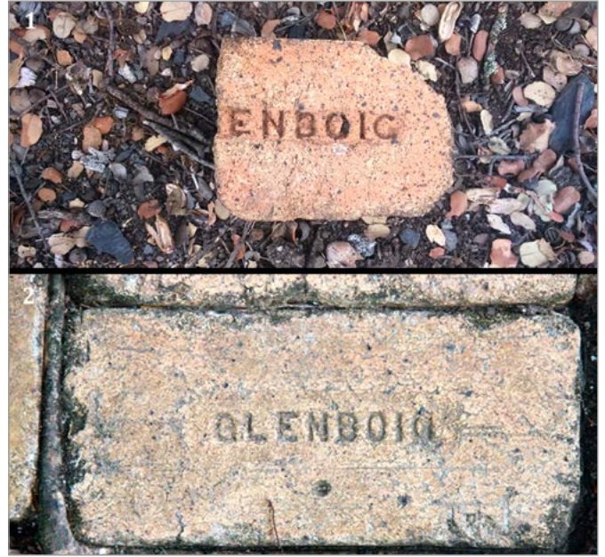
Fig. 34. 1) Fragmento de un ladrillo hallado junto a la casa de máquinas del pozo maestro. Foto: I. Ramos (octubre 2017). 2) Ladrillo completo del mismo fabricante, Glenboig Fire-clay Co., sociedad constituida en 1872 en Glenboig (Escocia), hallado en Barbados. Fuente: web gracesguide.co.uk .
