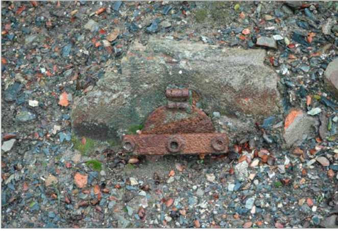
Fig. 41. Detalle A de la figura 42, donde se aprecia la compuerta que daría salida al agua del depósito hacia la planta. Foto: I. Ramos (marzo 2018).
