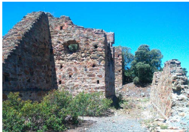
Fig. 32. Antiguo lavadero (vista lateral). Foto: R. Jiménez (mayo, 2017).
