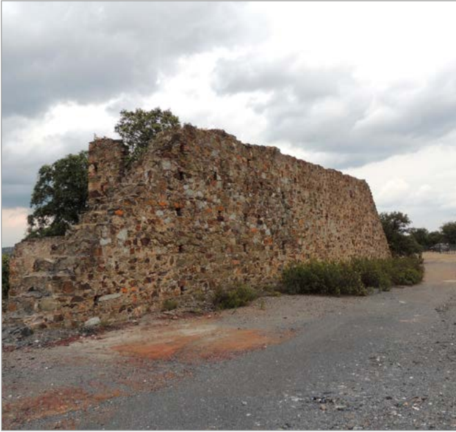
Fig. 33. Planta antigua de lavado (vista trasera). Foto: B. Rodríguez (abril 1917).
