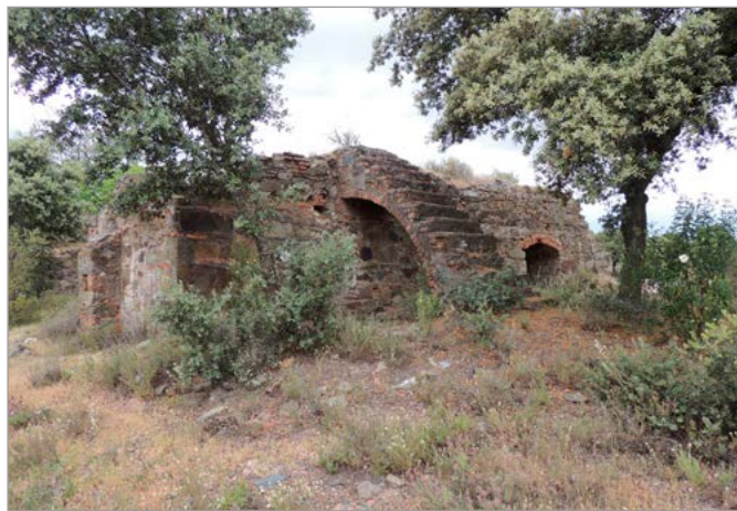
Fig. 24. Casa de máquinas del pozo maestro. Foto: B. Rodríguez (abril 2017).
