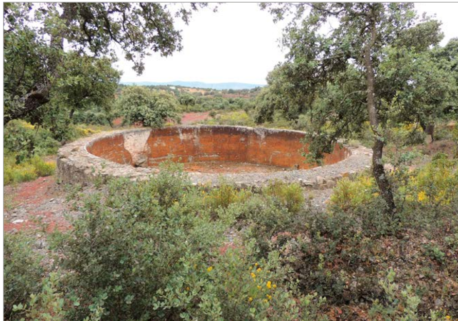
Fig. 39. Depósito de unos 157 m 3 , que con total probabilidad suministraba el agua necesaria a la antigua planta de lavado. Foto: B. Rodríguez (abril 2017).
