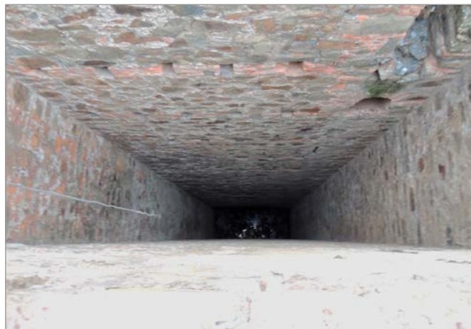
Fig. 20. Caña del pozo maestro, mamposteada en sus primeros 30 metros. Foto: B. Rodríguez (abril 2017).
