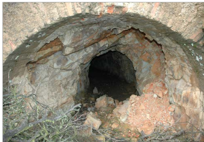
Fig. 29. Otra vista más cercana de la entrada a la posible "obra de canalización" del estéril de planta hacia la tolva para relleno. Foto: I. Ramos (marzo 2018).
