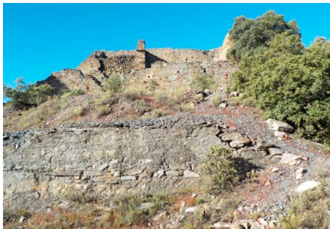
Fig. 31. Antiguo lavadero (vista frontal). A la izquierda se aprecia lo que aparentemente era una tolva para verter el mineral desde arriba. Foto: I. Ramos (mayo 2017).
