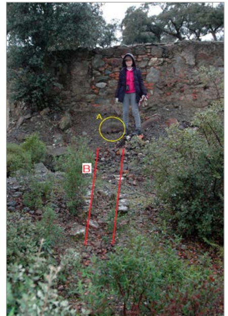
Fig. 40. Pequeña compuerta (A), situada al pie del depósito de agua, y restos de canalización (B) en dirección a la planta de lavado. Foto: I. Ramos (marzo 2018).
