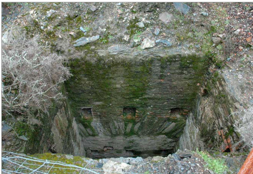
Fig. 21. Por su ubicación y por sus características constructivas, probablemente se trate del pozo denominado 'Este', también revestido de mampostería. Foto: I. Ramos (marzo 2018).
