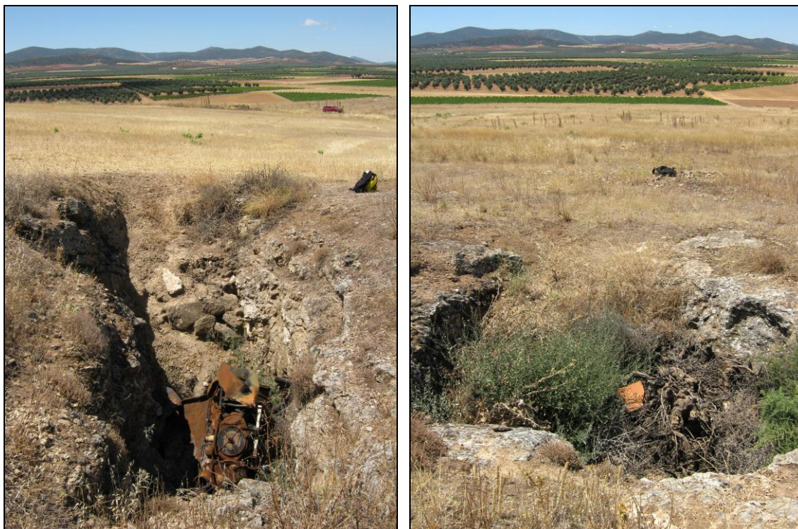
Figuras 30 y 31: Izquierda: Zanja inclinada en el Punto 4 de las labores localizadas. Derecha: Calicata en el Punto 4.
