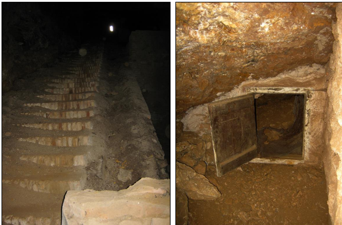
Figuras 54 y 55: Izquierda: Plano inclinado con escaleras y raíles, con la tronera al fondo en el interior del socavón que está a 50 m al N de la "Majada de Desiderio" en el Punto 15. Derecha: Portillo en la galería de la izquierda al final del socavón que está a 50 m al N de la "Majada de Desiderio" en el punto 15.
