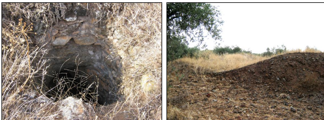
Figuras 73 y 74: Izquierda: Pozo vertical de sección circular en el Punto 20 de las labores localizadas. Derecha: Escombrera formando una plataforma en el Punto 20.
