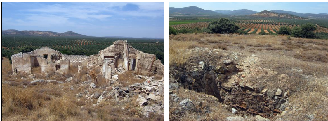
Figuras 82 y 83: Izquierda: Casa de la Mina en el Punto 22 de las labores localizadas. Derecha: Pozo y plataforma formada por la escombrera en el Punto 22.
