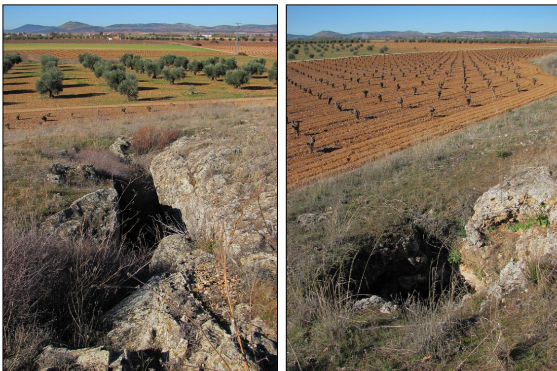
Figuras 24 y 25: Izquierda: Zanja localizada en el Punto 1. Derecha: Pozo vertical en el Punto 2 de las labores localizadas.
