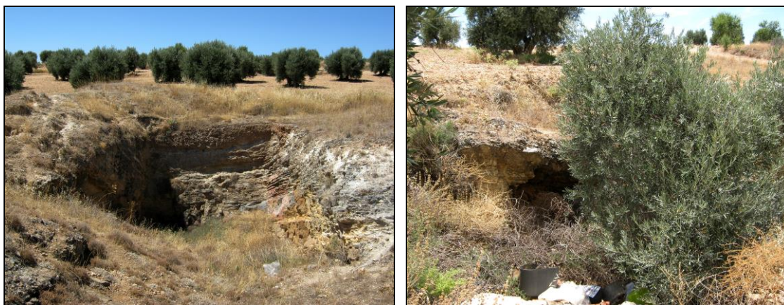
Figuras 50 y 51: Izquierda: Zanja inclinada en el Punto 13 de las labores localizadas. Derecha: Calicata o pozo inclinado cegado en el Punto 14.
