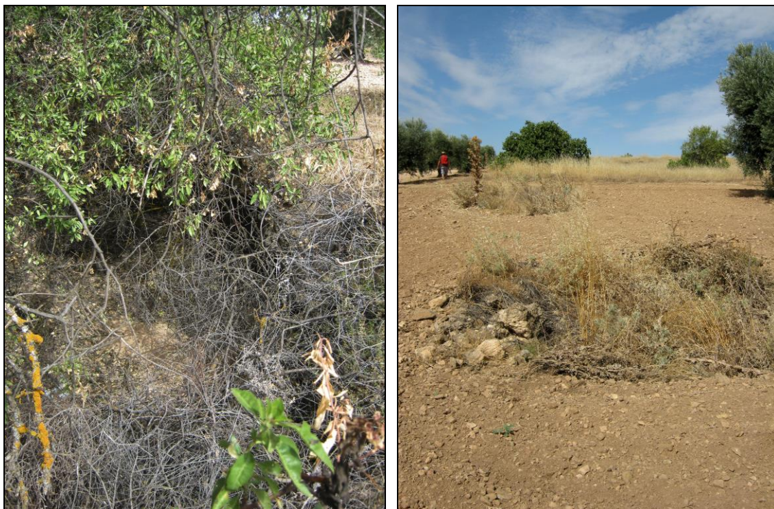
Figuras 62 y 63: Izquierda: Calicata o zanja rellena de vegetación en el Punto 16 de las labores localizadas. Derecha: Varias calicatas próximas y rellenas con escombros en el Punto 17.
