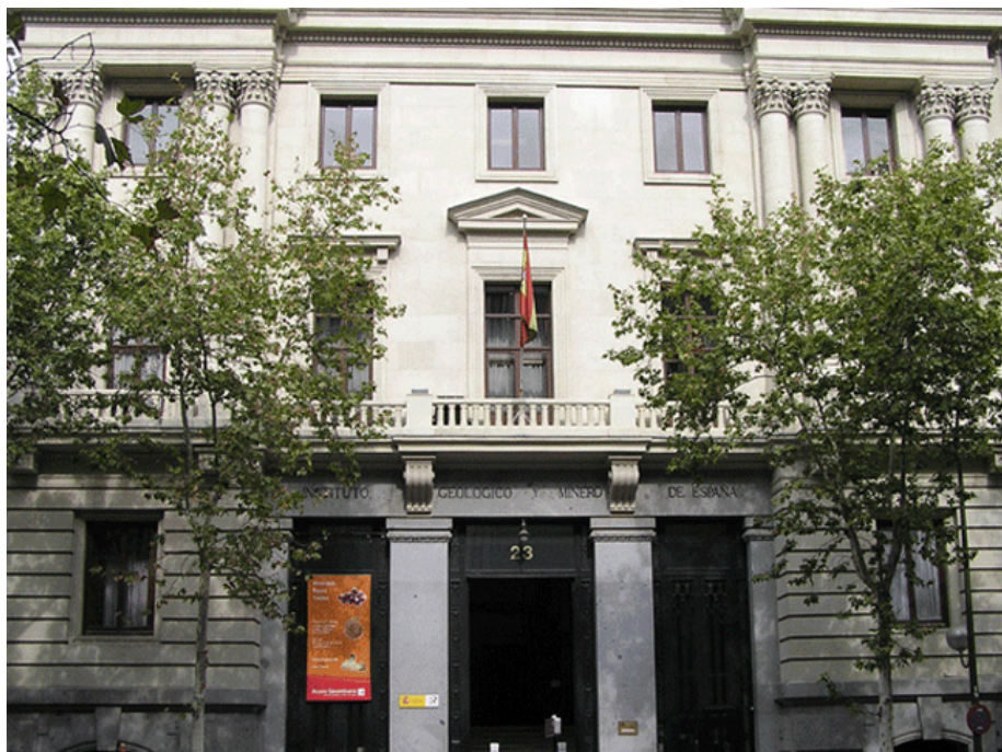
Fachada de la sede del IGME en Madrid, Ríos Rosas 23. Foto: Archivo IGME
