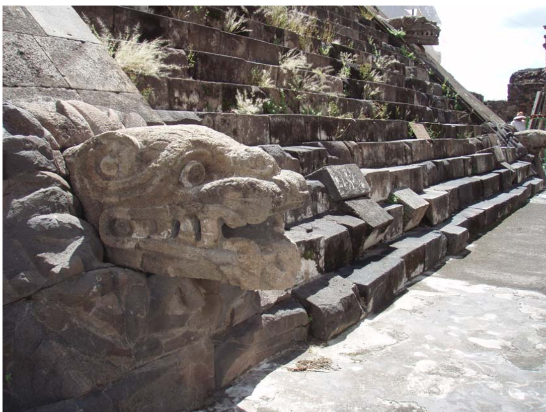
Efectos de un terremoto histórico entre los años 300 y 600 AD afectando a la escalinata oeste de la estructura original del Templo de la Serpiente Emplumada o de Quetzalcóatl, situado en la Ciudadela (Teotihuacan, México DF). Foto: Raúl Pérez
