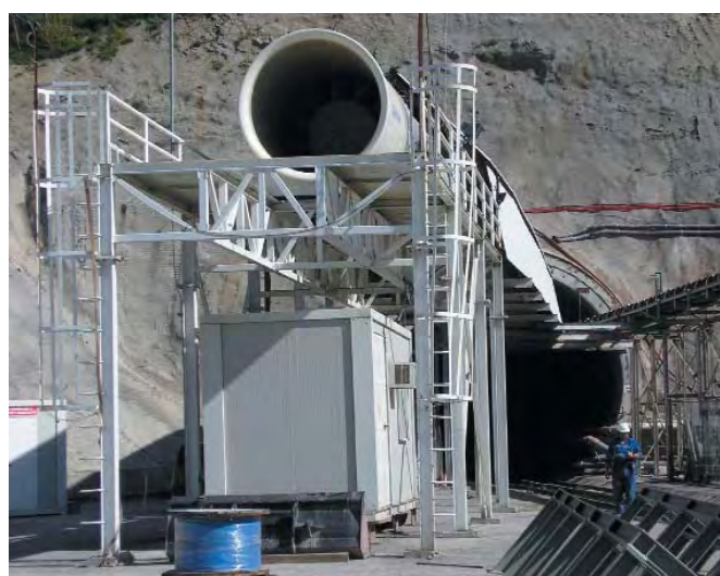
Pozo de sequía vertiendo agua a una acequia. Valencia Túnel de la línea de Alta Velocidad León-Oviedo
