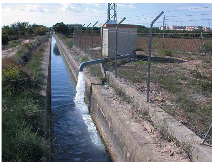
Pozo de sequía vertiendo agua a una acequia. Valencia
