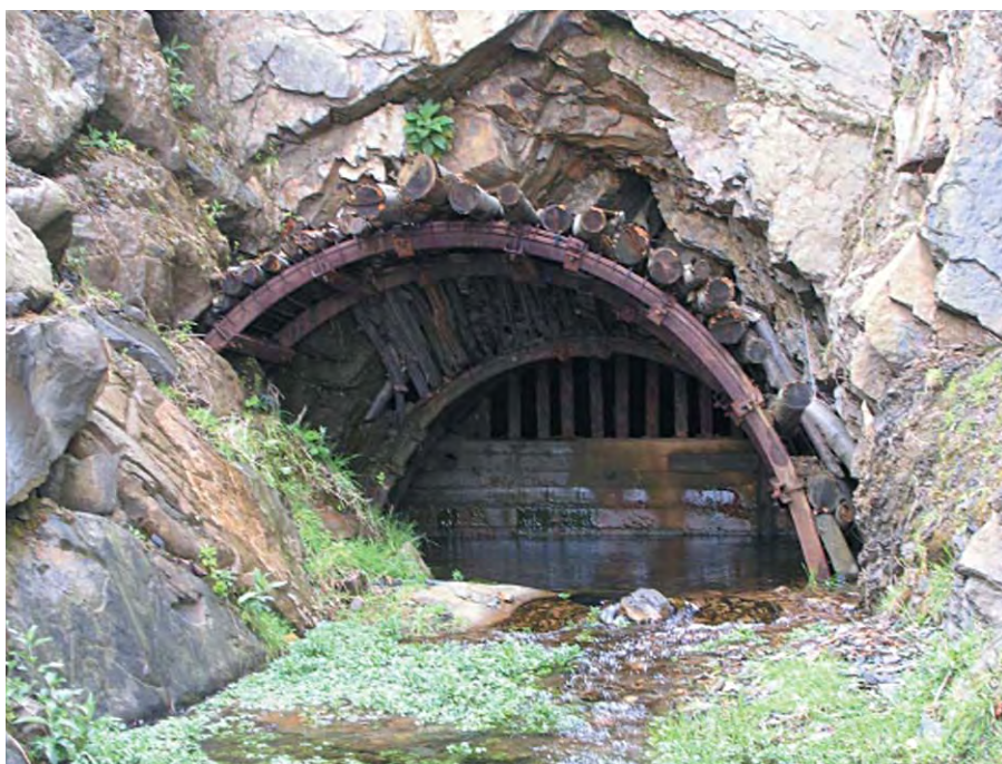
Clausura de una bocamina de explotación de carbón en la Cuenca Central Asturiana
