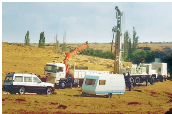
Figura 2. Equipo de perforación GEOMITASE 45, diseñado por el IGME y Talleres Segovia S. L., en Cabañas (Ávila), año 1992. Fotografía: Antonio N. Martínez Sánchez de la Nieta.
