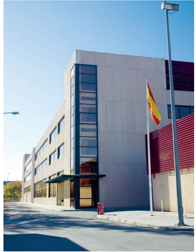
Figura 66. Edificio del IGME en la calle Calera n.º 1 de Tres Cantos (Madrid). Archivo del Instituto Geológico y Minero de España, CSIC.
