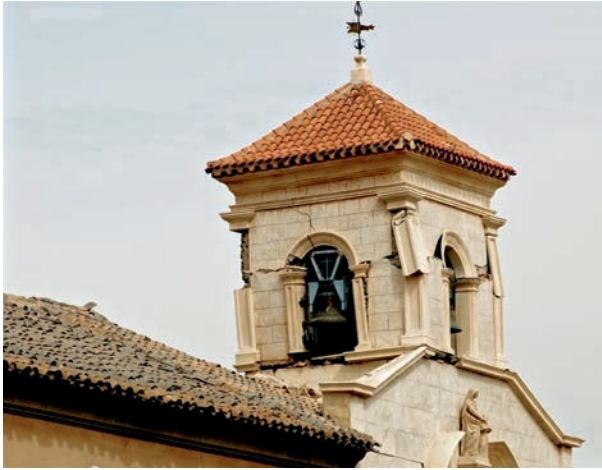
Figura 2. Efectos del terremoto de Lorca de 2011 sobre el patrimonio cultural: campanario del Convento de las Clarisas. Foto de los autores.
