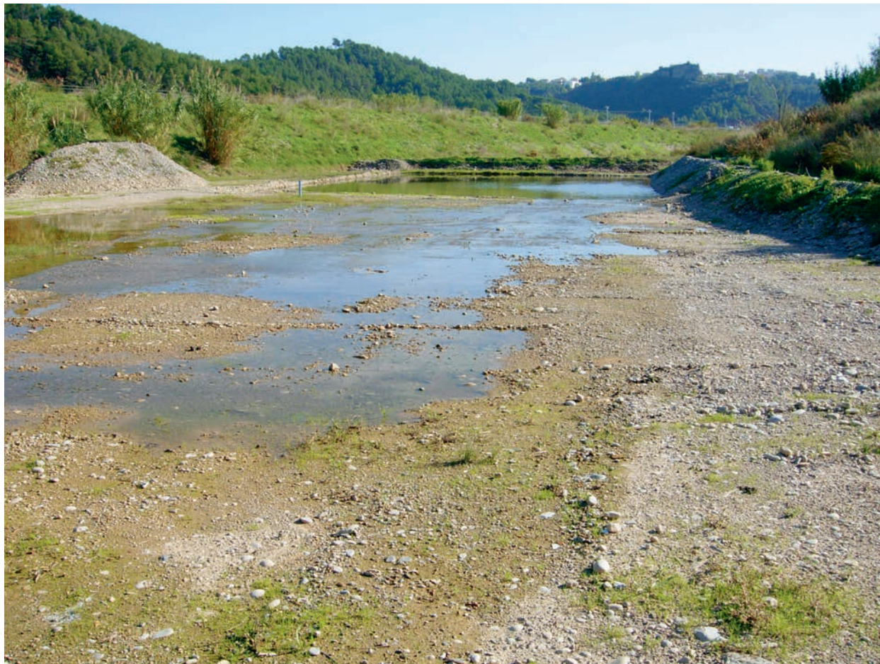
Figura 1. Balsa de recarga en el acuífero aluvial del río Llobregat. Fotografía: Jose Antonio de la Orden.
