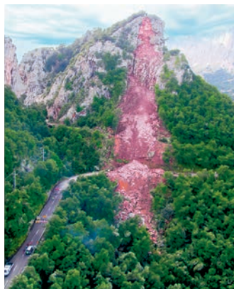
Figura 1. Izquierda, vista de la cabecera del deslizamiento de Benamejé, Córdoba (1989) afectando a viviendas y calles de la población. Fotografía: M. Ferrer. Derecha, avalancha rocosa en la serra de Tramuntana, Mallorca (2008), que cortó la principal carretera de la región durante casi cuatro meses. Fotografía: R.M. Mateos.
