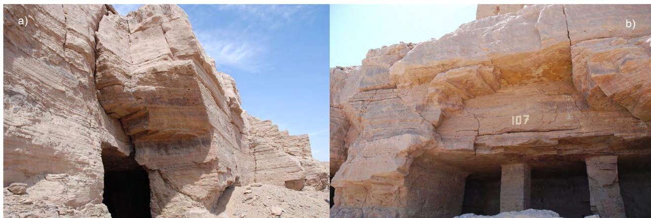
**Figura 9.** Derecha: Tumba QH107 con el mismo tipo de rotura planar que la tumba QH34h, donde se observa la rotura de un dintel de roca con un estrato horizontal. Izquierda: Tumba QH109 con diaclasa favorable a la rotura planar. Ejemplo de la posición del bloque antes del deslizamiento.
