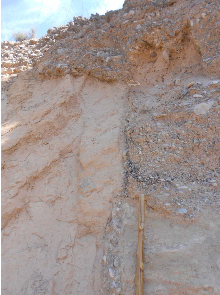
Figura o Foto 18: Falla con evidencia de arrastre en la capa de gravas justo encima del bastón.
