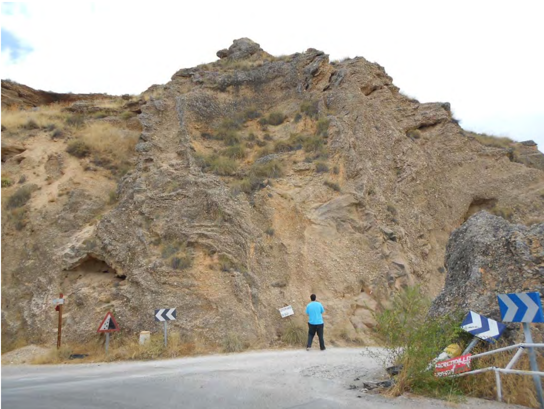
Figura o Foto 28: Zona próxima al puente sobre el Tajo.
