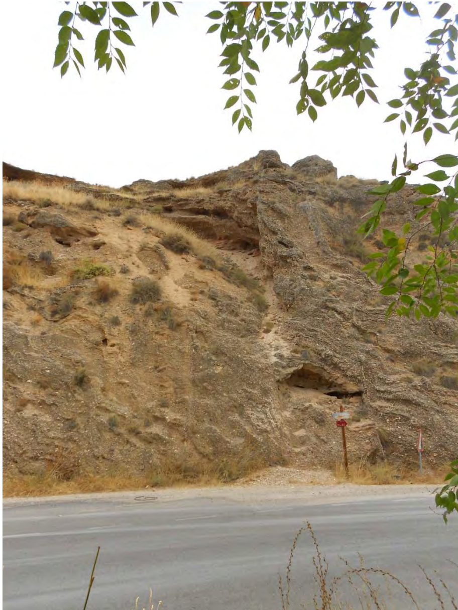
Figura o Foto 26: Falla vertical.
