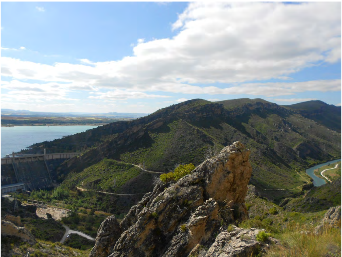
Figura o Foto 32: Presa de Buendía y valle estructural del Guadiela (a la derecha).
