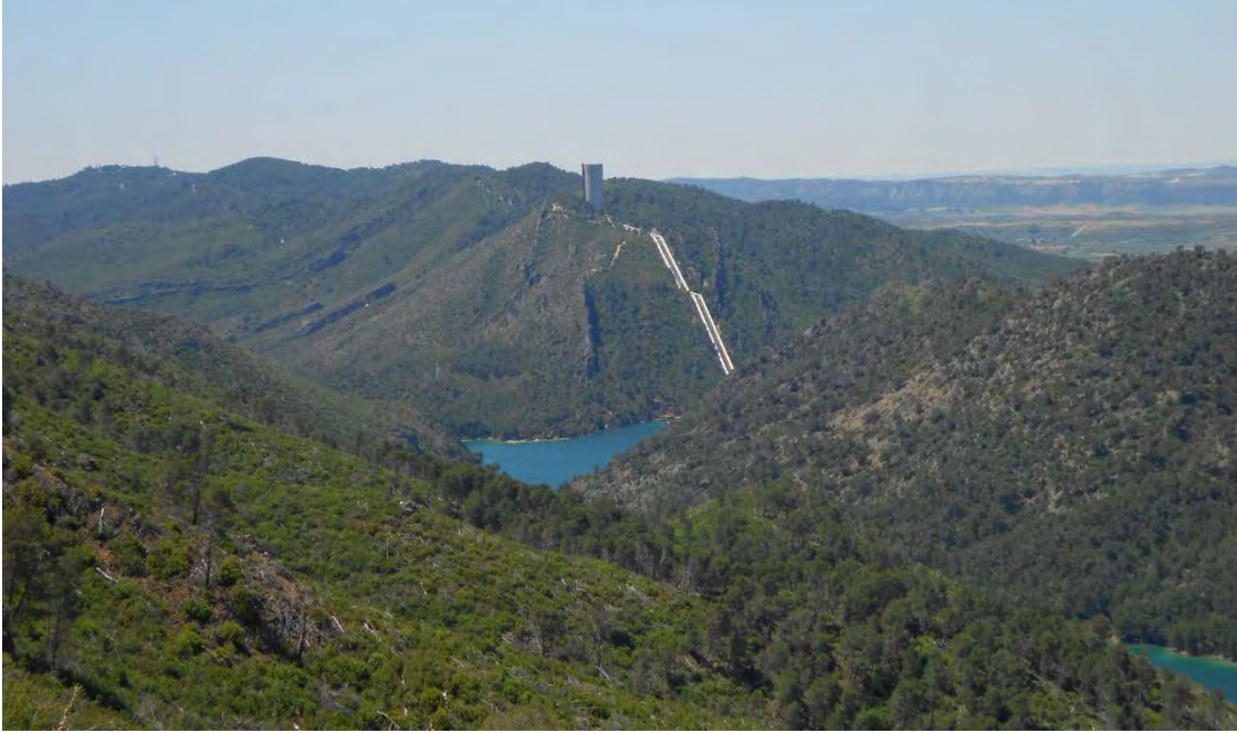
Figura o Foto 33: Junto a la presa de Bolarque (no visible) captación del trasvase Tajo-Segura. Arriba, torre de bombeo. A la derecha, de forma difusa se aprecia la Cuenca de Madrid.
