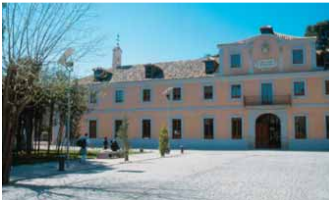
Foto de la fachada principal del edificio Sabatini durante la inundación de marzo de 1947, con los obreros evacuando enseres en barca (a); y situación actual de la misma zona (b).
