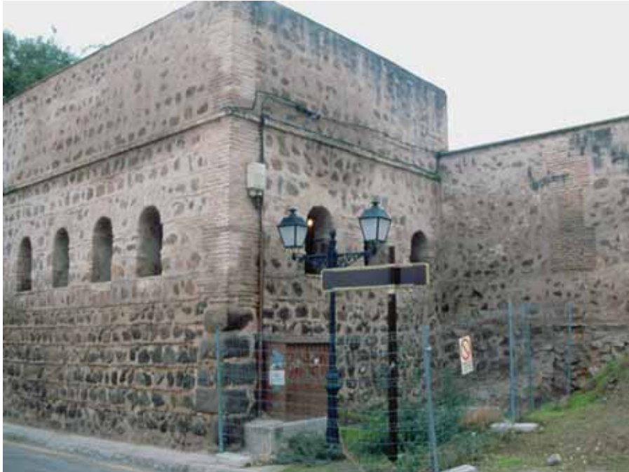
Vista del lateral exterior derecho de la antigua Puerta del Vado.
