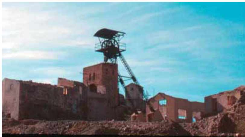
Restos de las antiguas minas del entorno del arroyo de Guajaraz, en las que destaca el castillete metálico.
