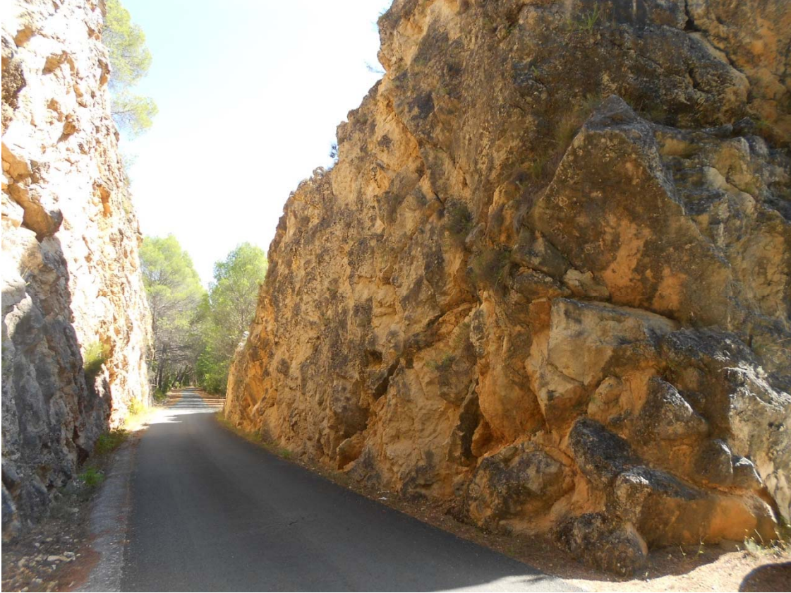
Figura o Foto 16: Flanco Oeste del pliegue atravesado por la carretera (antigua traza de ferrocarril) en la que se aprecia una capa vertical muy adelgazada con todo tipo de fracturas coherentes con la generación del pliegue de propagación de falla.
