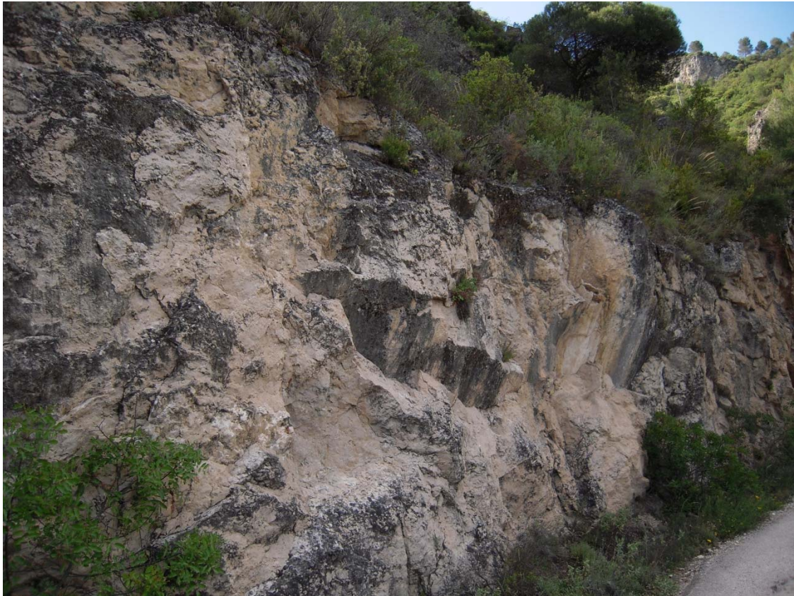
Figura o Foto 23: Planos de falla en la carretera que transita por el margen izquierdo del río Tajo.
