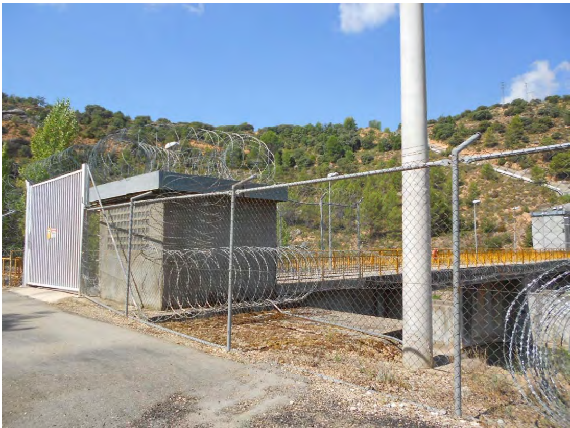
Figura o Foto 27: Instalaciones de la Central Nuclear de Trillo.
