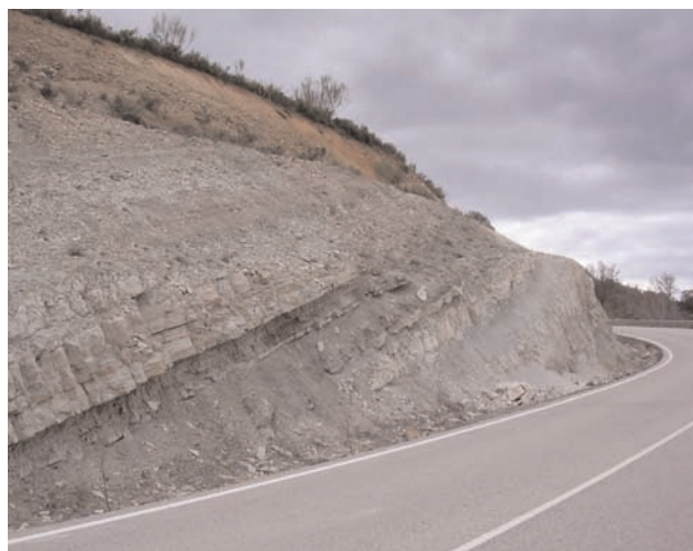
Fotografía 7. Unidad de Beleña del Sorbe en la carretera de Puebla de Beleña a Cogolludo.
