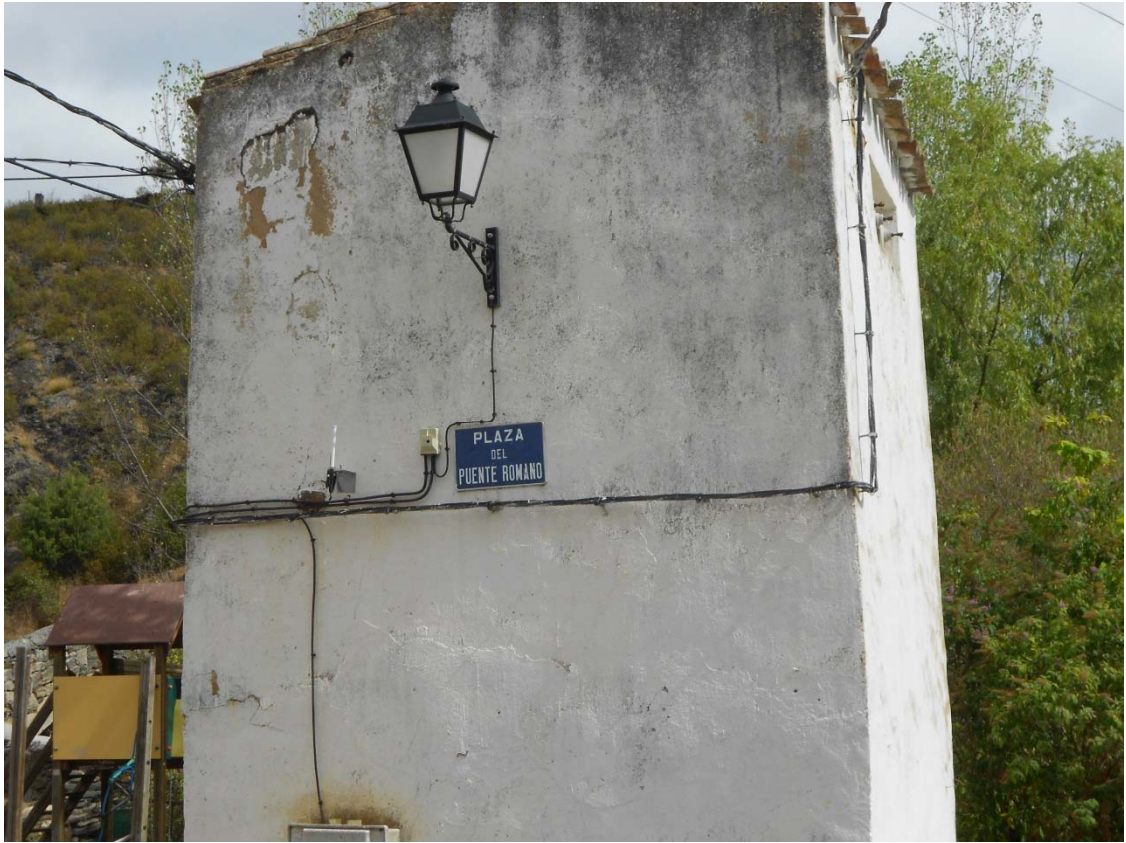
Figura o Foto 25: Plaza del "Puente Romano".
