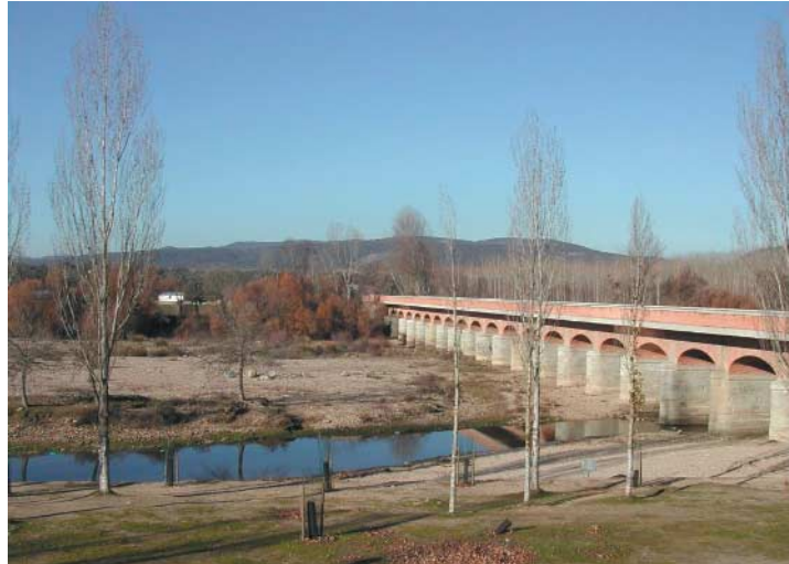
Figura 63: El Puente de la Pedrera fue construido a finales del siglo XVIII de grani- to y ladrillo en una zona donde el río Alberche se reorienta hacia el sur en dirección al río Tajo. La dinámica fluvial hace que de un año para otro pueda cambiar la posi- ción del canal activo. Compara esta foto del mes de Diciembre de 2005 con lo que ves en tu visita.
