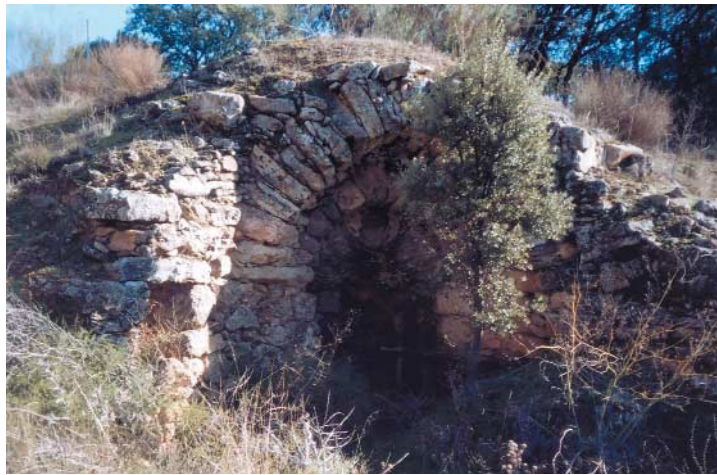
Figura 100: Entrada al horno en el que se aprovechaban las rocas carbonáticas del Cretácico superior para obtener cal.
