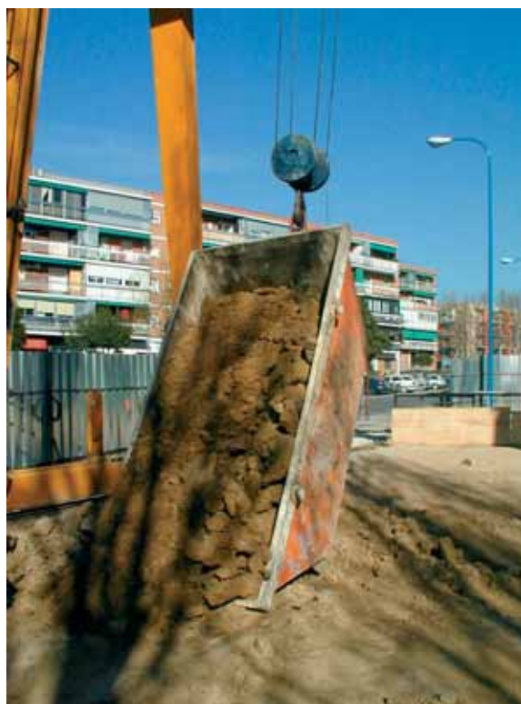
Figura 57. Vacíos para la construcción del Metro, suponen grandes movimientos de tierras
