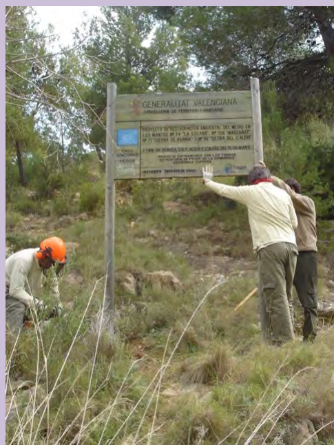
Figura 43: Retirada carteles viejos en la ruta del faro del Albir (l'Alfàs del Pi)
