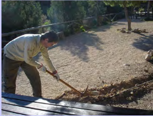
Figura 49: Soterramiento del riego por goteo en la ruta roja (L'Alfàs del Pi)
