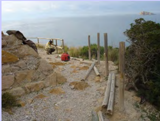
Figura 50: Construcción de vallado de seguridad en la Punta del Cavall (Benidorm)
