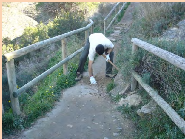
Figura 47: Relleno de socavones en ruta amarilla
