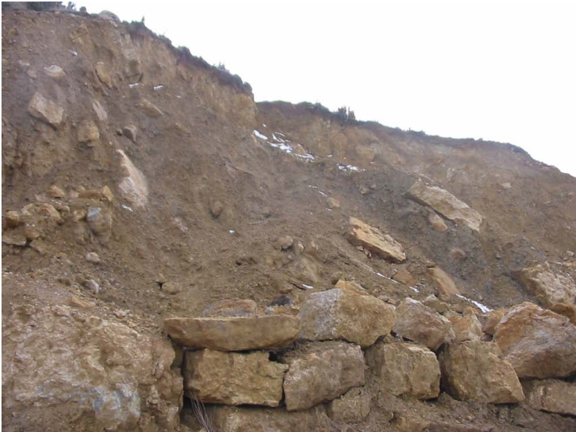
Detalle del deslizamiento (2003)
