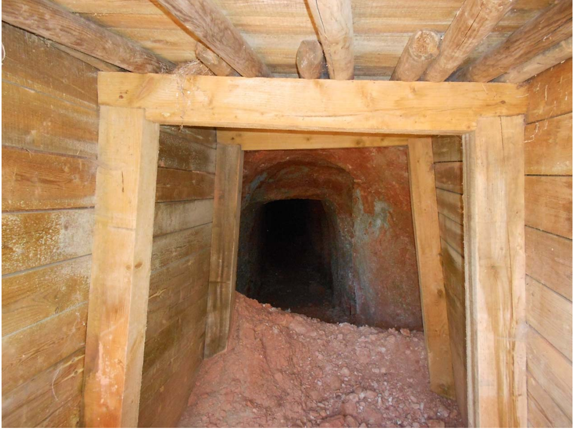
Figura o Foto 18: Galería de entrada a la mina.
