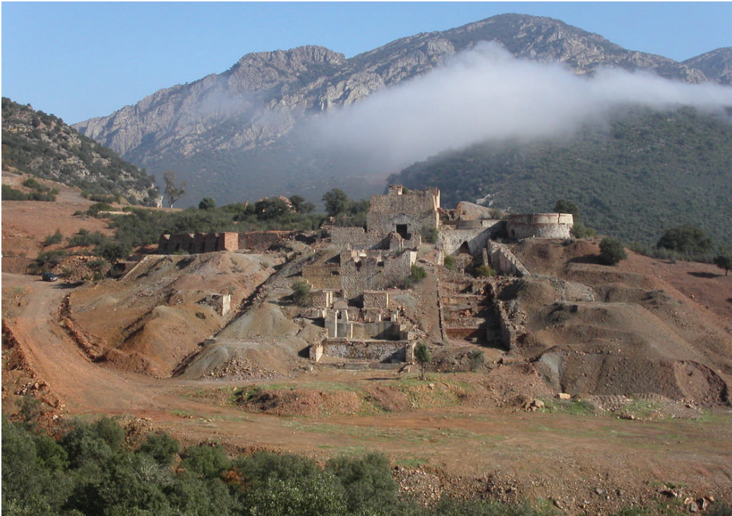
Lámina de fotos 4.- Estado actual de las ruinas del lavadero de flotación de las Minas de Los Pontones del Coto Minero de El Hoyo de Mestanza.
