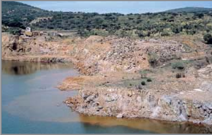
Aspecto actual de la corta Adelaida, con el fondo inundado. Tras la parada de los trabajos, unas lluvias torrenciales provocaron la entrada masiva de aguas en la cantera y en el resto de instalaciones, causando graves deterioros. Foto: Gonzalo García.
