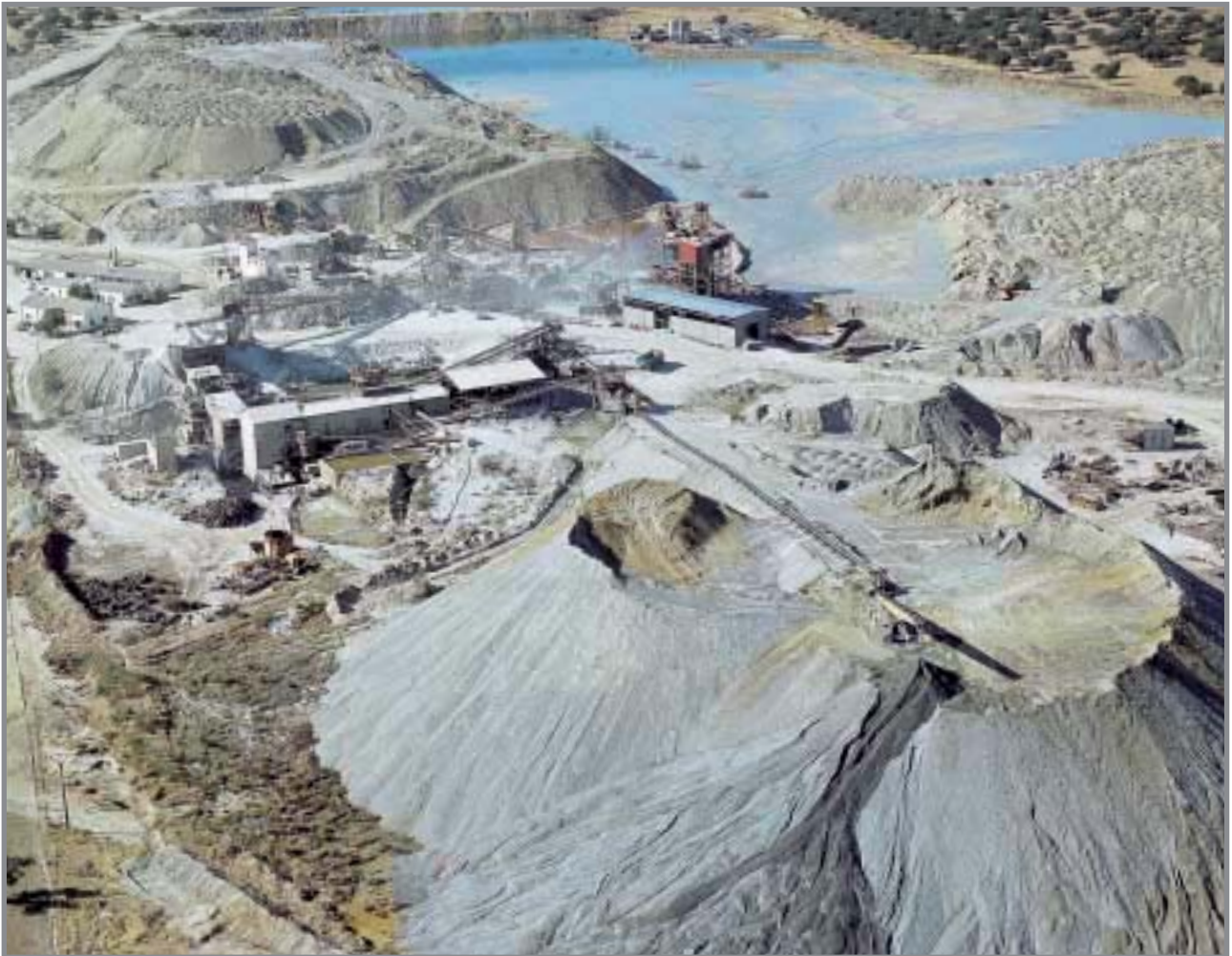
Perspectiva general de las instalaciones de concentración de la mina en 1984. Obsérvese, en primer término, los voluminosos acopios de finos procedentes del lavadero. Esta fracción contiene un significativo contenido en scheelita y casiterita, resultante de una recuperación incompleta en las líneas de concentración gravimétrica del lavadero. Para el reciclado y aprovechamiento de esta riqueza se constituyó la sociedad Wolframexsa, que puso en marcha una planta de extracción con tecnología de la casa Eral, S.A. Al fondo se observa la planta de recuperación de arsénico. Foto: Paisajes Españoles, S.A.
