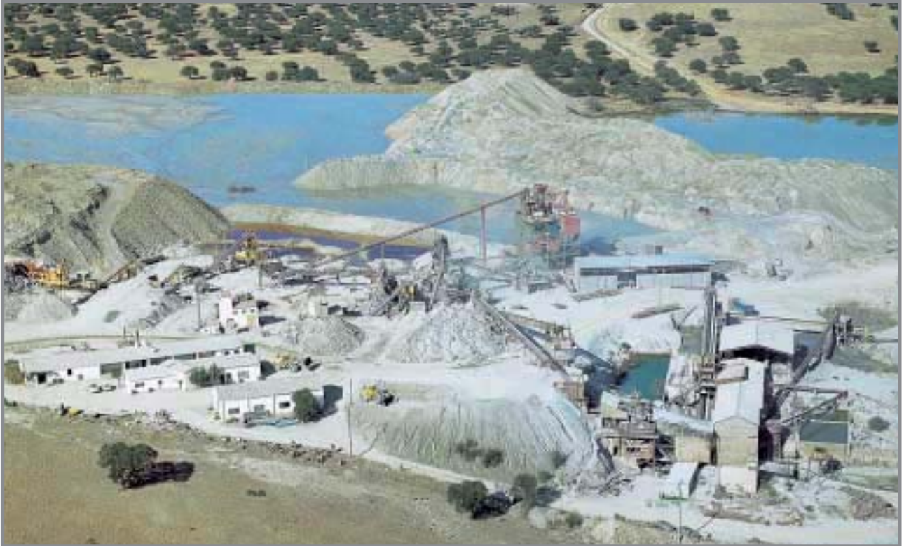
Vista general de las instalaciones de trituración (parte izquierda de la foto) y concentración del todo-uno (primer plano, derecha y posterior, en estructura roja), oficinas y laboratorios de la mina, en octubre de 1984. La capacidad nominal era de 300 t/h, con un volumen de producto en torno a 100 t/mes de scheelita, totalmente destinada a la exportación. Foto: Paisajes Españoles, S.A.
