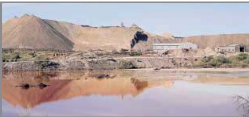
Panorámica de acopios de finos de la planta y almacenes, en 1989. El color rojizo de las aguas es debido a la oxidación de los sulfuros del yacimiento. Estas aguas, consideradas como curativas en tiempos del balneario, hoy serían seguramente calificadas como un peligroso contaminante para el medio ambiente. Foto: G. García.
