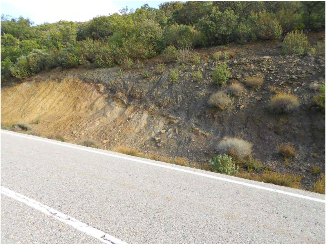
Figura o Foto 8: Otra vista del afloramiento previo.
