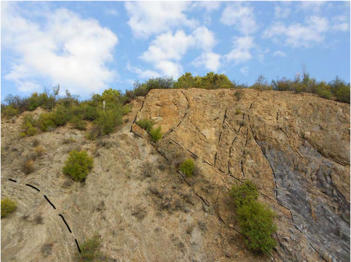
Figura o Foto 46: Detalle de un tramo en el que se aprecia una falla normal en el centro de la foto.
