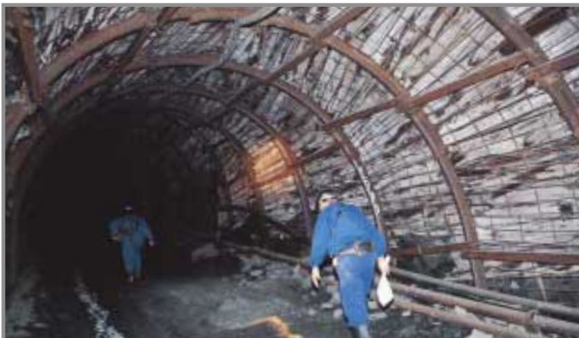
FOTO 18.- Mina de Almadén, Rama Sur. Tramo de la rampa de acceso de la Planta 14ª al subnivel de 9ª, revestido con cerchas metálicas en U y rollizos de madera. Esta rampa fue construida en los años 1980 y ha sido la infraestructura básica en la última etapa de explotación en la Rama Sur, la cual permitía el acceso de la maquinaria y personal en la explotación por grandes cámaras mediante barrenos largos.
