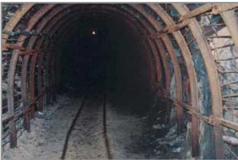
FOTO 14.- (Planta 9ª de la Mina de Almadén). Galería de Poniente que sirve de acceso a las explotaciones de la Rama Sur desde el Pozo San Teodoro. Labor realizada en la década de los años 1960, tras el redescubrimiento de las mineralizaciones situadas bajo los antiguos trabajos de la Mina del Pozo y La Contramina.
