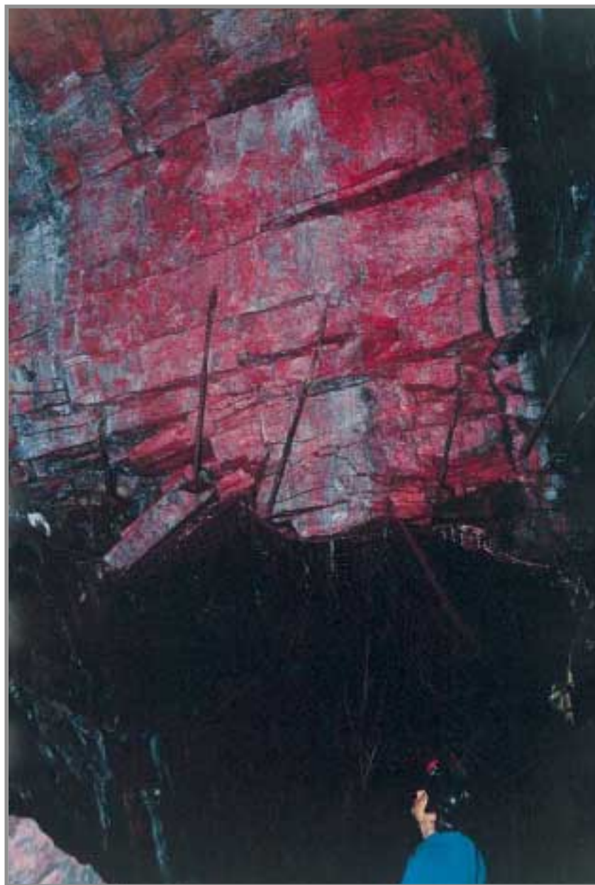
FOTO 31.- Planta 19ª de la Mina de Almadén, Rama Mina. Mineralización de alta ley del Banco de San Pedro, en el techo de una explotación por el método de corte y relleno. El frente corresponde al resto de un "deslave", como se llamaba a la retirada del último tajo del realce que ya daba al piso de la planta superior. Se conservan restos de la sujeción del techo del anterior realce mediante bulones y mallazo.
