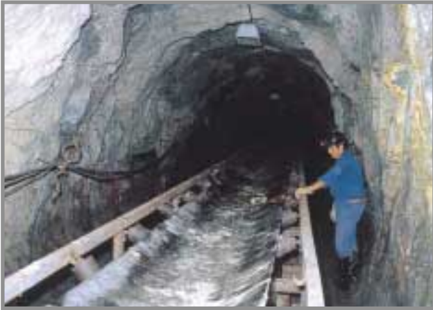
FOTO 24.- Planta 15ª de la Mina de Almadén. Cinta transportadora en la galería general, la cual ha sido utilizada para la extracción de minerales por el Pozo San Joaquín en la última etapa de explotación de la mina.
