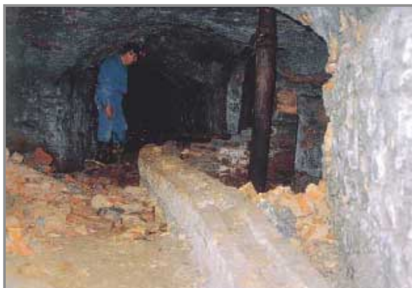
FOTO 10.- Planta 5ª de la Mina de Almadén. Canalizaciones de cerámica para la conducción de aguas en una galería transversal de acceso a las explotaciones de San Francisco y San Nicolás. Trabajos del siglo XIX.
