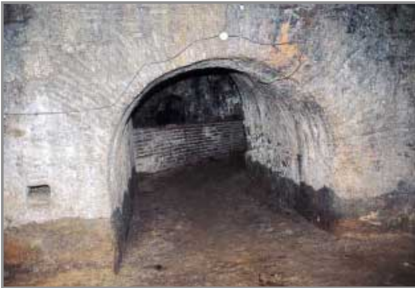
FOTO 5.- Mina del Castillo, Planta 1ª de la Mina de Almadén. Hueco del baritel y galería de acceso al pozo interior de San Andrés. Labores de la primera mitad del siglo XVIII revestidas de ladrillo y piedra.
