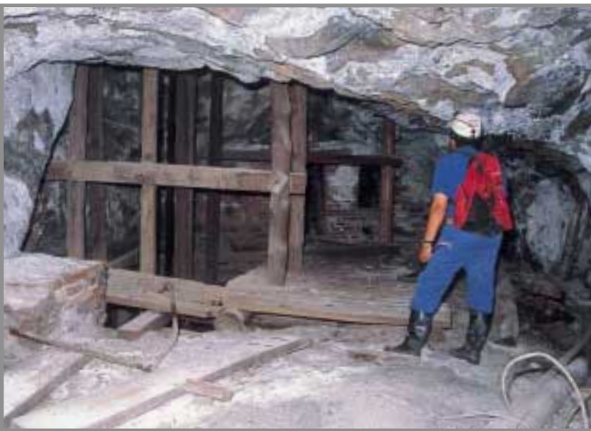
FOTO 4.- Mina del Pozo, Planta 1ª de la Mina de Almadén. Embarque de la 1ª Planta en el Pozo San Aquilino, construido en madera. El guionaje también es de madera y se encuentra en perfecto estado. Es de comienzos del siglo XX pero ha sufrido modificaciones hasta la década de 1950.
