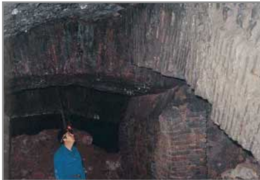
FOTO 9.- Planta 5ª de la Mina de Almadén. Sitio de Santa Clara. Sostenimiento con arcos de ladrillo utilizados en la explotación por el método de Larrañaga. Trabajos de la primera mitad del siglo XIX.
