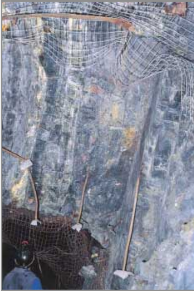
FOTO 15.- Planta 9ª de la Mina de Almadén, Rama Sur. Explotación por el método de corte y relleno del 3º Macizo. En la foto se pueden ver los bulones de sostenimiento del techo en el frente de avance del corte, así como el mallazo de sujeción del nuevo techo del realce tras la voladura, limpieza y saneamiento. Estas labores son de finales de los años 1970.
