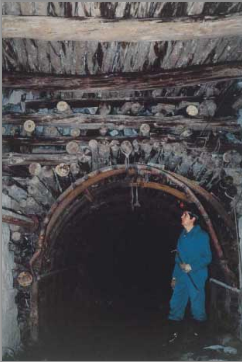
FOTO 30.- Planta 19ª de la Mina de Almadén, Rama Mina. Sostenimiento combinando cerchas metálicas en U, cuadros de madera y relleno con rollizos. Trabajos realizados para proteger una zona debilitada de las Pizarras de Muro en la galería general de Levante.
