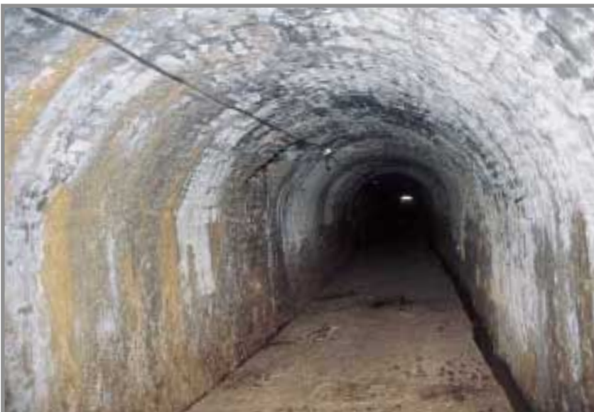
FOTO 6.- Mina del Castillo, Planta 1ª de la Mina de Almadén. Socavón de acceso de la Mina del Castillo. Este socavón se construyó entre 1703 y 1706, y está revestido en su totalidad por muros de mampostería y bóveda de cañón de ladrillo.
