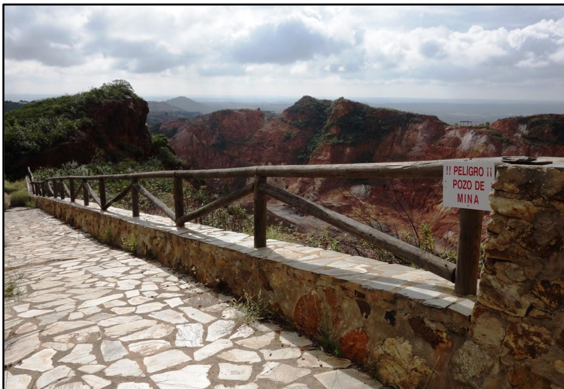
Vallado y señalización de peligro de un camino que da a la corta Filón Sur.
