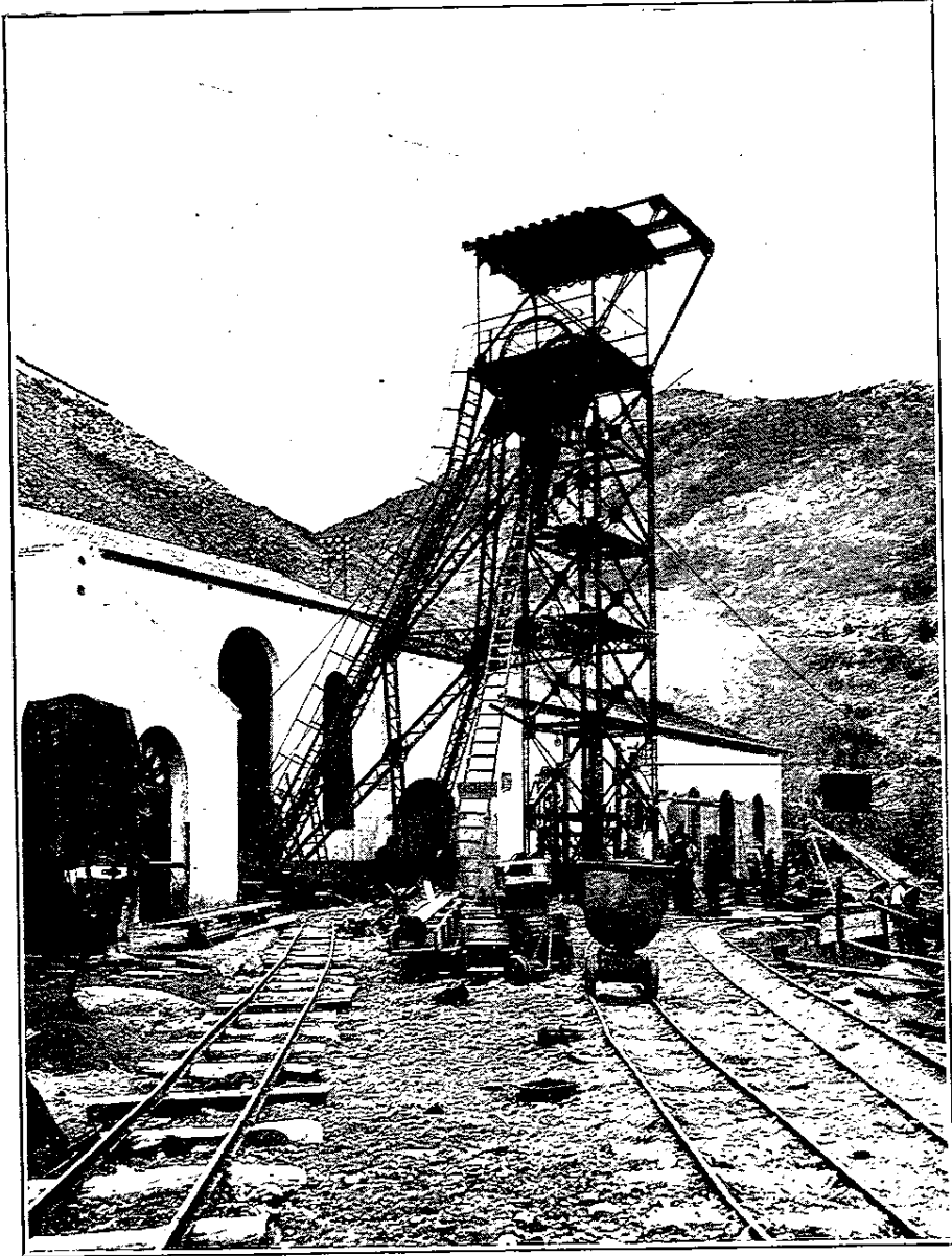
Pozo de extracción
