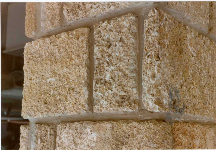
11-45/AD-BA/43.- Aspecto de la "piedra ostionera" a "facies ostionera", del Plioceno Superior-Pleistoceno de la Bahía de Cádiz, en su utilización para la construcción (Caja Postal de Ahorros del Puerto de Santa María).
