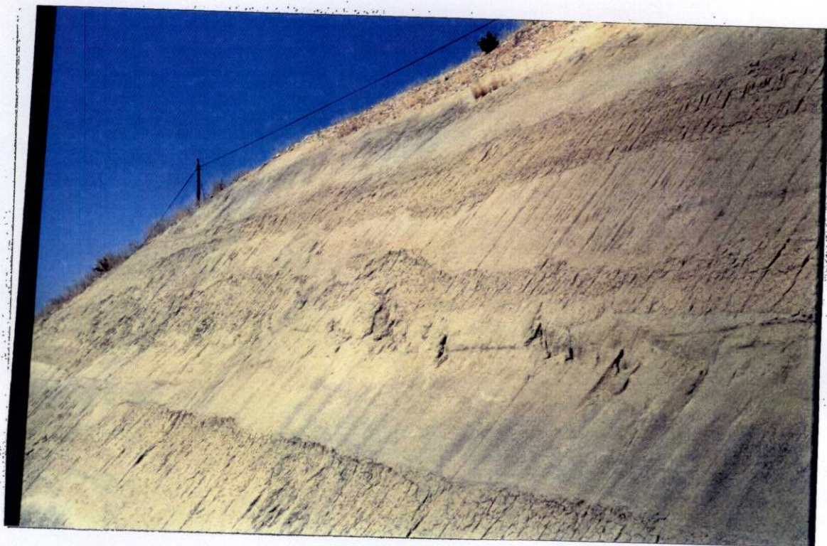
MS- 9233.- Unidad arcósica (19) en el cruce de la N-V con la carretera de Cardiel de los Montes. Véase el amalgamiento de los cuerpos de arcosas más gruesas.
