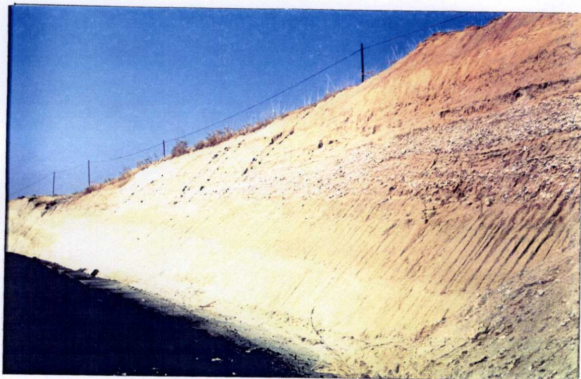
MS- 9238.- Contacto entre una terraza alta (25) y la unidad arcó- sica (19) en un talud de la carretera N-V.
