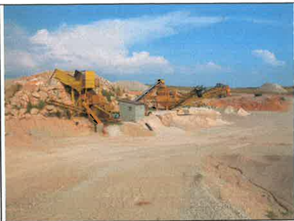
Foto nº 20. Planta de machaqueo y clasificación. Explotación nº 28
